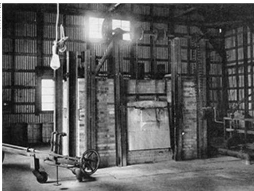
Nel 1923 Nippon Kogaku organizza la Oi Glass, reparto fusione con la fornace da 500kg e il crogiolo da 350kg e con piccoli forni per i test e celle per il raffreddamento delle fusioni arrivate dalla Germania.
